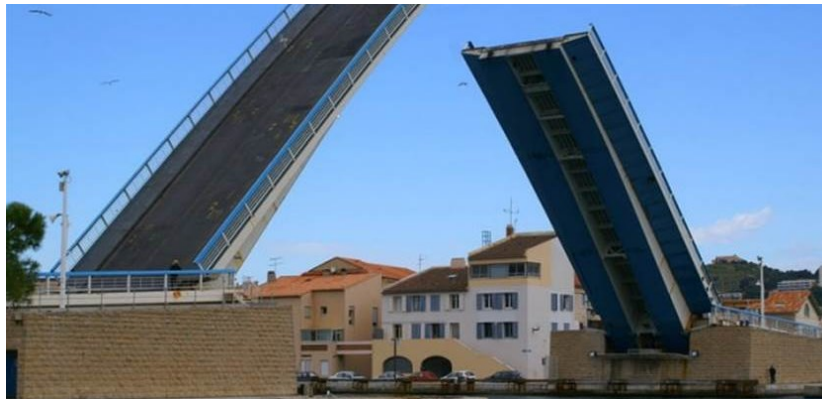
Infrastructure de franchissement du chenal compatible avec la navigation maritime
